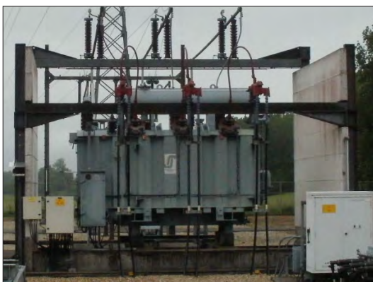
Un transformateur 90 000/20 000 volts et ses murs pare-feu
