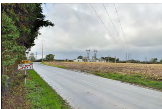
Vue sur le poste, depuis la D 71, en sortie d'agglomération
