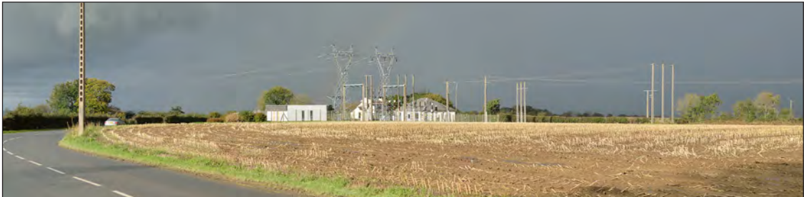
Vue rapprochée, au sud du poste
