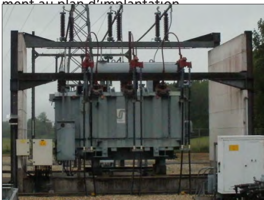
Un transformateur 90 000/20 000 volts et ses murs pare-feu
