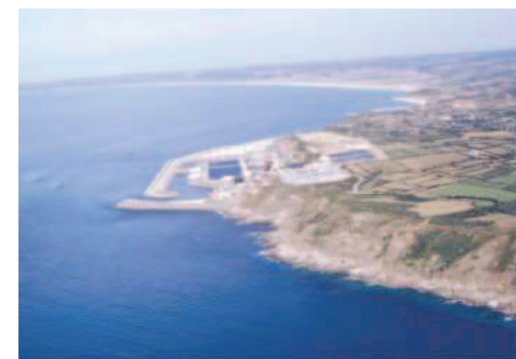
Figure 127 : Centrale de Flamanville, au creux de la falaise
