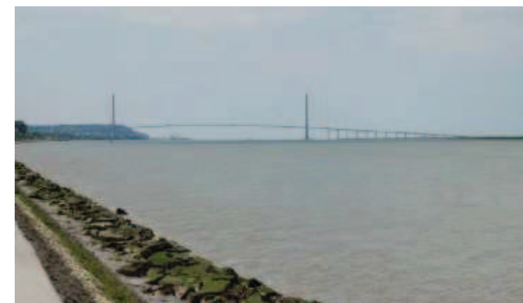
Figure 142 : Le Pont de Normandie vue de Bréville-sur-Mer
