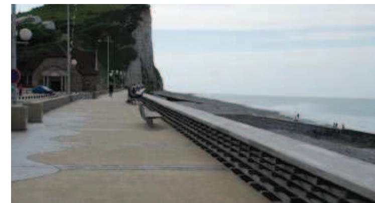
Figure 147 : Digue réaménagée sur l'embouchure de la Durdent (Veulette-sur-Mer)
