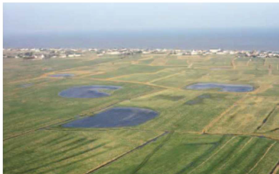
Figure 132 : Gabions et constructions balnéaires du cordon dunaire
