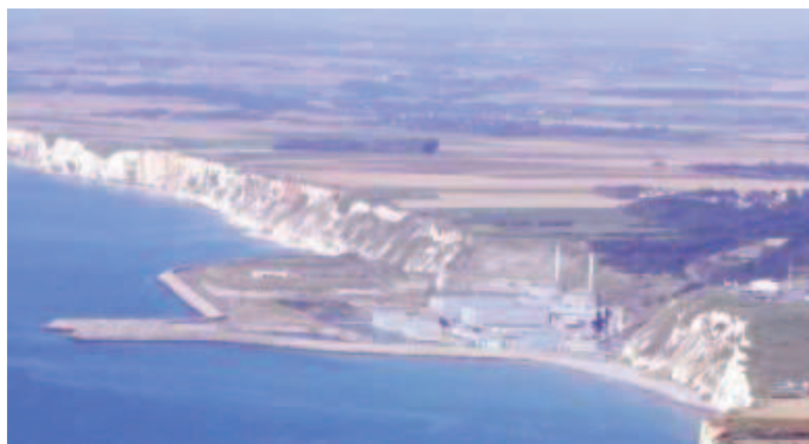
Figure 152 : La centrale électro-nucléaire de Penly
