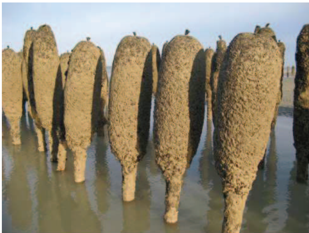
Figure 224 : Pieux de moules à Quend lage les pins recouverts de vase à Polydora ciliata , le 3 mars 2010 (Ruellet, 2011)
