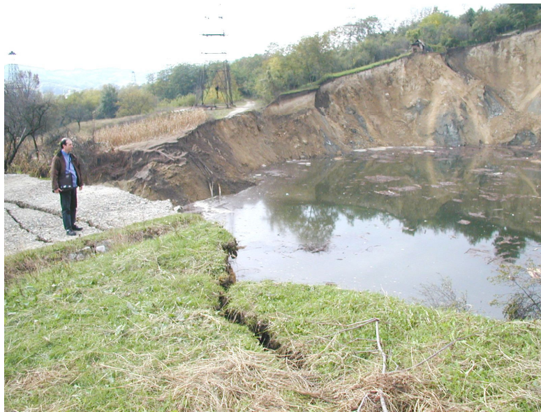
Photo 4 : L'effondrement partiel de la caverne d'Ocnele Mari (Roumanie), le 8 octobre 2001, a provoqué une vague qui a causé des dégâts importants aux installations et habitations situées à l'aval.
