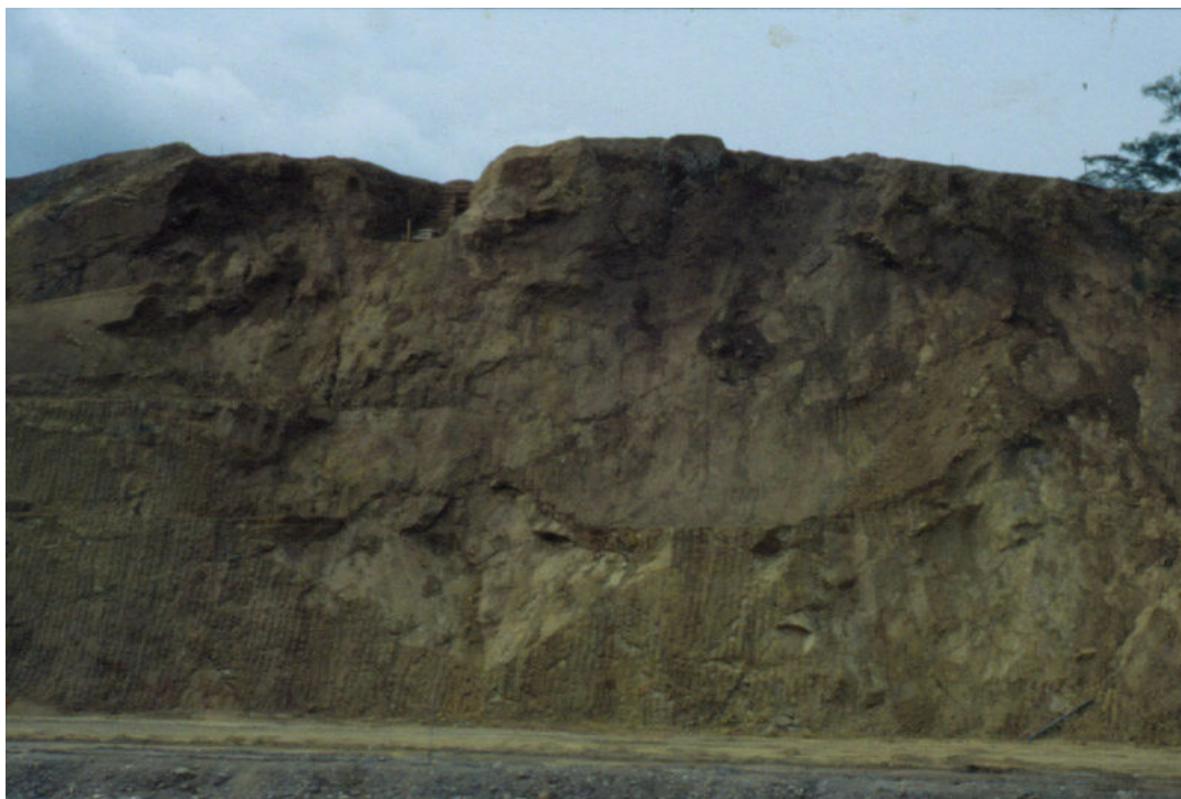
Photo 11 : Exemple de glissement dièdre. On discerne sur la photo la zone d'arrachement d'où s'est détaché le dièdre (Mine d'or d'Ity-Côte d'Ivoire).
