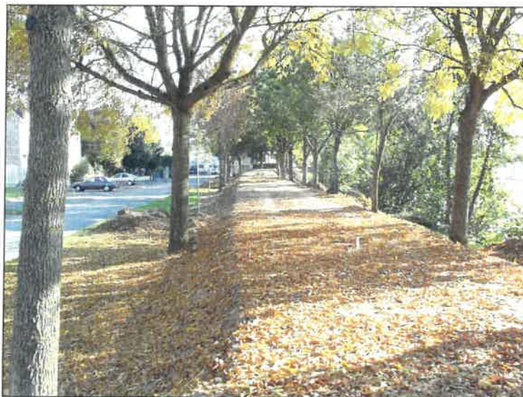
Digue de protection le long de l'Orne à Louvigny
