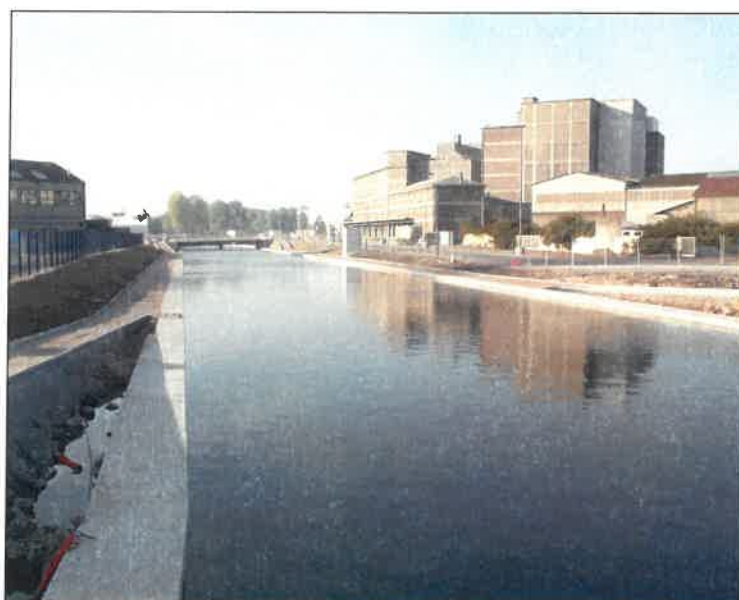
Canal de jonction entre le l'Orne et le canal maritime
