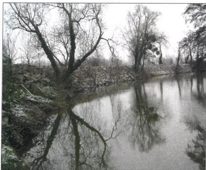
Digue de protection de Fleury sur Orne
