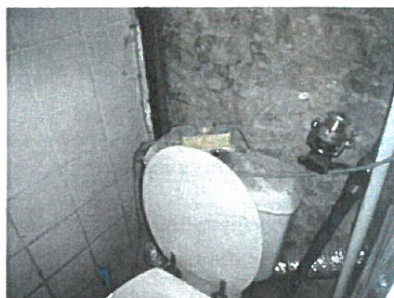
Dans le cabinet d'aisance du rez de chaussée
