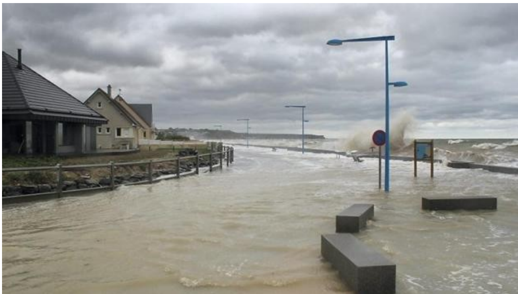
Figure III.51: Franchissements par paquets de mer et submersion marine sur la digue d'Asnelles (photo prise en novembre 2013 au niveau de la rue du Débarquement, transmise par la DDTM Bayeux).
