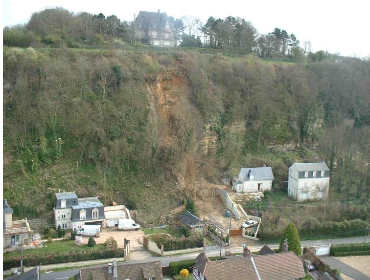
Figure n°4 : photographie le 4 avril 2001 d'un départ de matériaux au sommet de la falaise supérieure des « Creuniers » à Trouville-sur-Mer (source : DIREN Basse-Normandie - SIDPC du Calvados).
