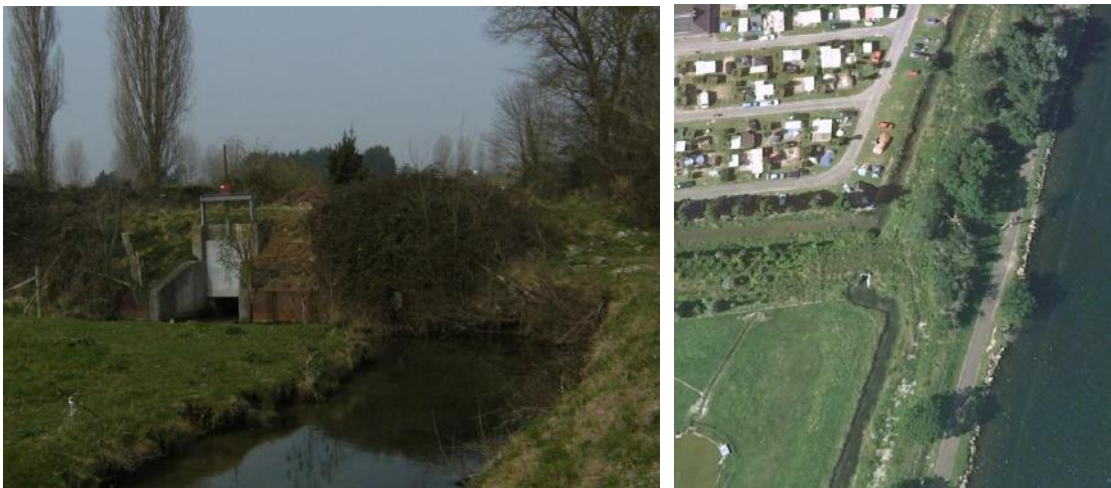
Figure 2-14: Ouvrage dans le fossé de ligne, sud du camping.
