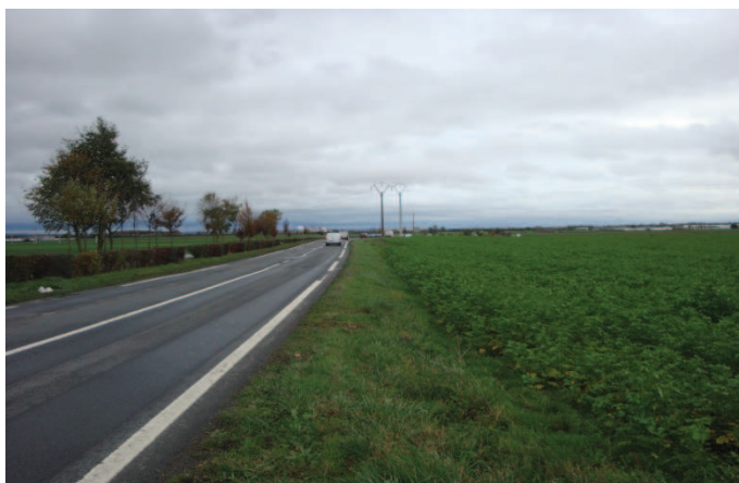
RD 229 à proximité Nord de la zone d'étude, 6 novembre 2015
