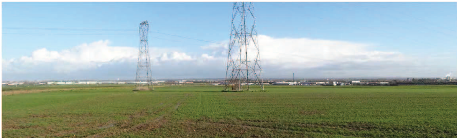
Vue depuis l'entrée du village d'Hubert Folie. Le site est peu visible car la topographie est presque plane, il est relativement éloigné et se fond dans la frange urbaine (vue n°9).
