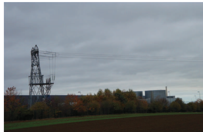
Ligne haute tension « Dronnière - Percy » (90 kV) Partie Sud de la zone d'étude 6 novembre 2015
