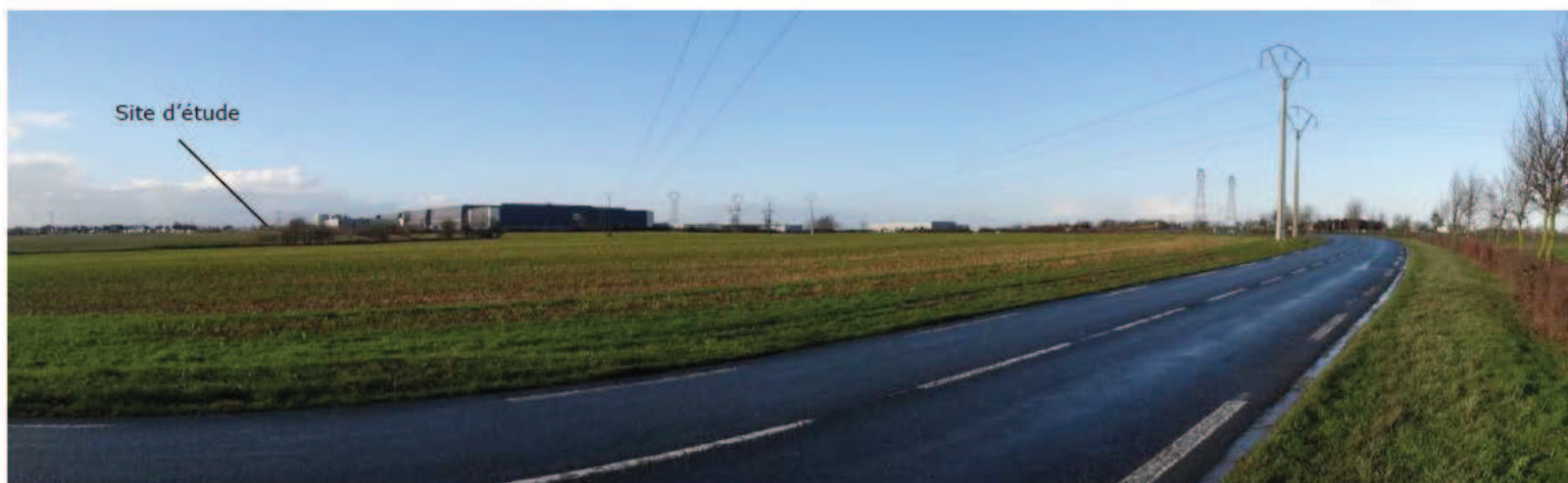
Vue sur le site d'étude depuis la RD 229 et piste cyclable. Il n'y a pas d'enjeux paysagers, la perception de l'agglomération de Caen n'est pas visible de cet angle de vue (vue n°7).
