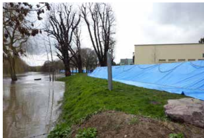
Digue de protection à Louvigny
