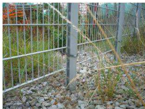
Photo 30 : Exemple de clôture perméable à la petite faune
