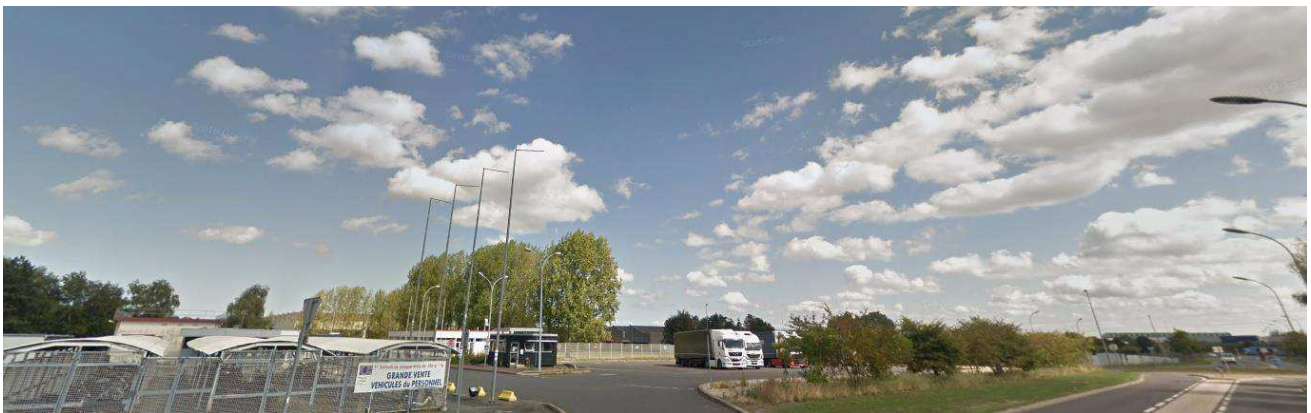
Vue des terrains du projet depuis le Boulevard de l'Espérance à proximité de l'entrée du futur site (8)
