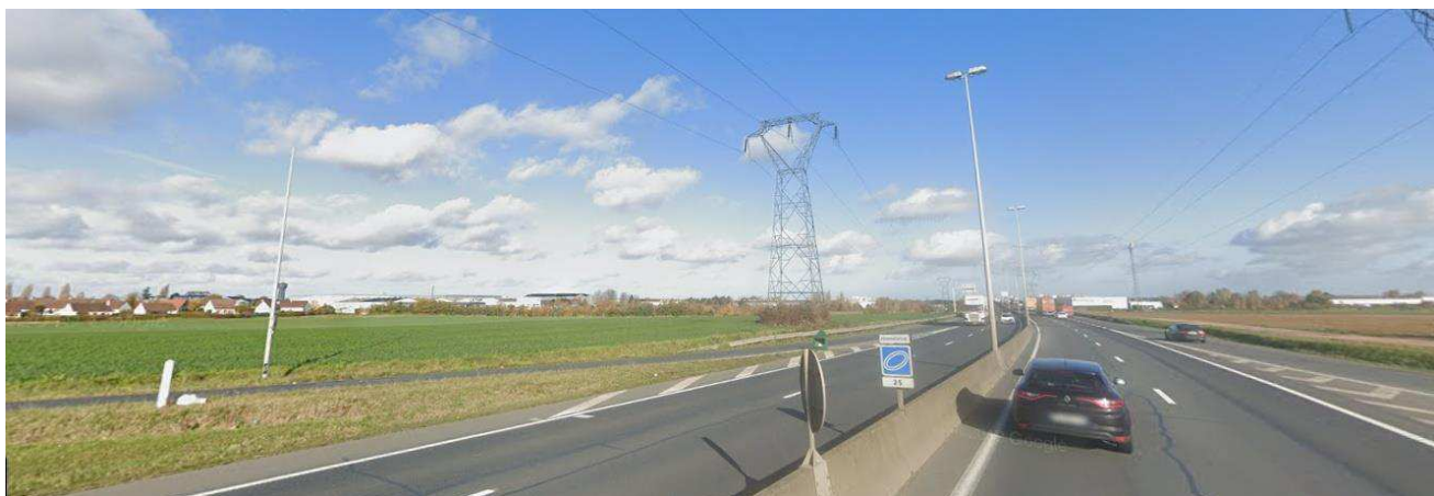
Vue en direction du projet depuis le Boulevard périphérique de Caen au Sud (6)
