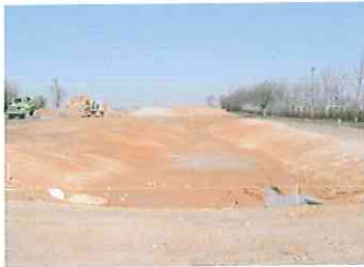
Bassin enherbé sec avec débit de fuite vers le réseau d'eaux pluviales et surverse vers le talweg naturel
