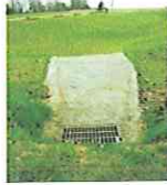
Bassin enherbé sec avec débit de fuite vers le réseau d'eaux pluviales et surverse vers le talweg naturel
