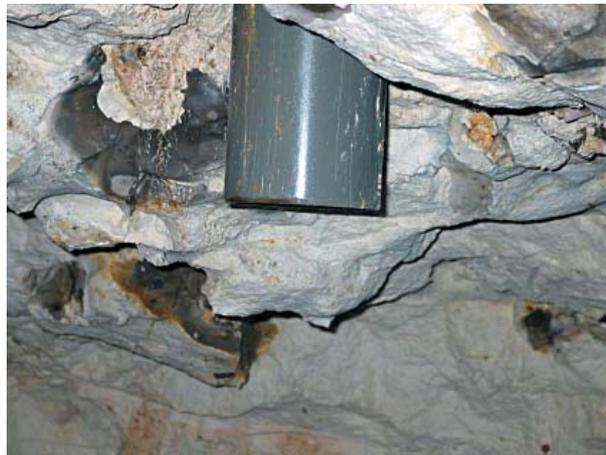
■ Fig. 67 - Fin de tubage d'un forage dans la marnière.
