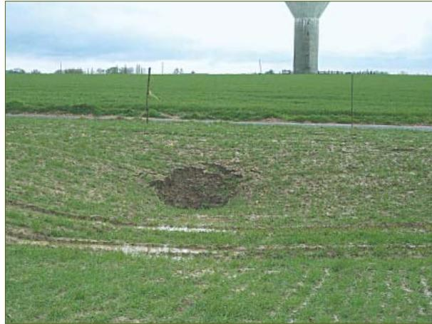
■ Fig. 35 - Dépression topographique de grande dimension en liaison avec la ruine d'une chambre de marnière : on peut observer l'ancien puits d'accès au centre de la photo.
