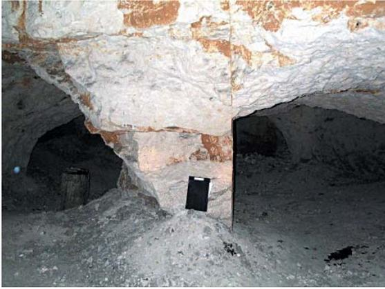
■ Fig. 14 - Pilier de manière souterraine : ruine du pilier sur la gauche et exploitation suivant la fracturation sur la droite.
