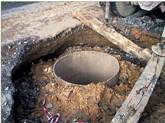
■ Fig. 71 - Puits creusé et busé en acier.
