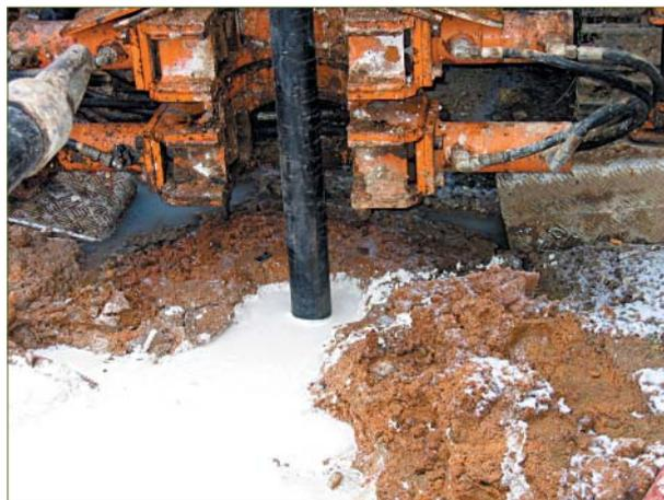
■ Fig.64 - Détermination de la nature des matériaux par l'observation des cuttings autour de la tête de forage et de la couleur de l'eau : sur ces clichés, l'eau brune correspond à l'argile à silex, l'eau blanche à la craie.
