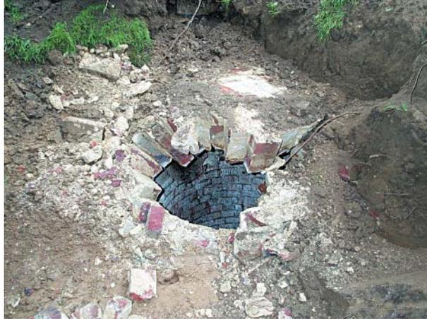
■ Fig. 24 - Puits dont l'orifice était fermé par une voûte briquetée.
