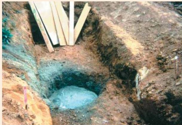
■ Fig. 80 - Comblement gravitaire d'une marnière par le puits.
