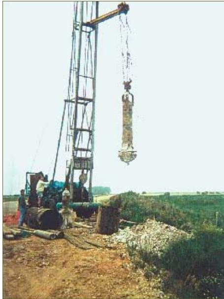
■ Fig. 70 - Curage d'un puits à l'aide d'un forage type « Bénoto ».
