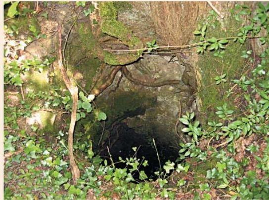
Le plus souvent, les marnerons réalisaient de part et d'autre du puits une galerie horizontale de 1 à 3 mètres de large pour 1 mètre de haut : l'œillard\* (cf. Fig. 6), qui amorçait l'exploitation en chambre\*. Cette zone servait au remplissage des paniers remontant la marne, les marnerons étant ainsi à l'abri de chute d'objets dans le puits, mais aussi de refuge aux ouvriers lors de l'effondrement du ciel d'une chambre.
