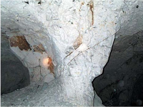
■ Fig. 26 - Pillier présentant des fractures biaises annonçant une rupture prochaine.
