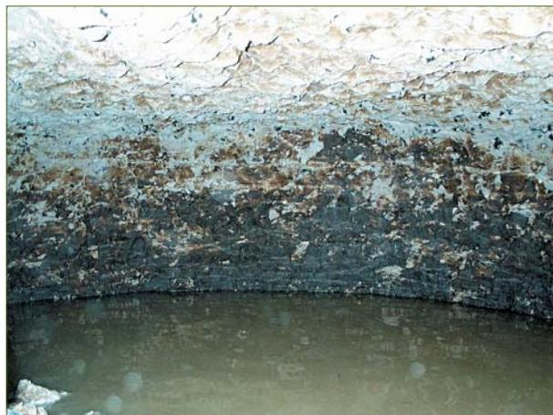
■ Fig. 43 - Marnière ennoyée par la nappe de la craie : le niveau maximal d'ennoyement est indiqué par la limite supérieure du nappage d'argile sur la paroi.
