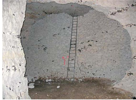
■ Fig. 15 - Marnière partiellement exploitée par hagues et bourrage.
