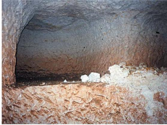
■ Fig. 20 - Chambre de marnière à simple et double hauteur d'exploitation.
