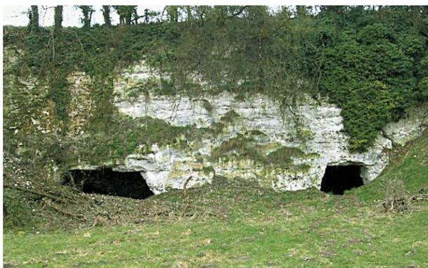
■ Fig. 3 - Entrée d'une marnière accessible en galeries horizontales à partir du front de taille\* d'une exploitation à ciel ouvert.
