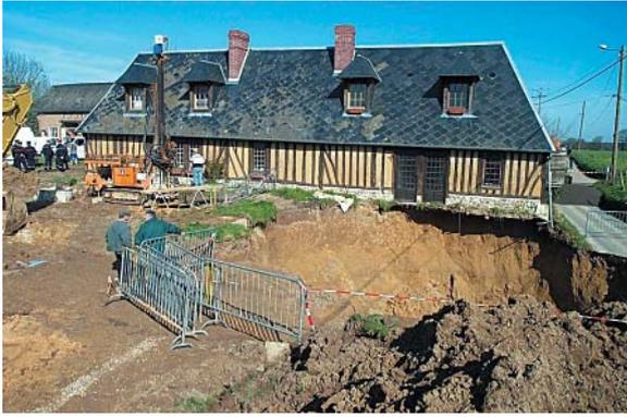
■ Fig. 39 - Effondrement ayant entraîné une victime (12 m de diamètre pour 7 m de profondeur).
