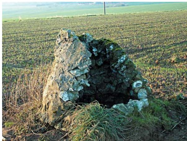
■ Fig. 23 - Dôme recouvrant un puits d'exploitation.
