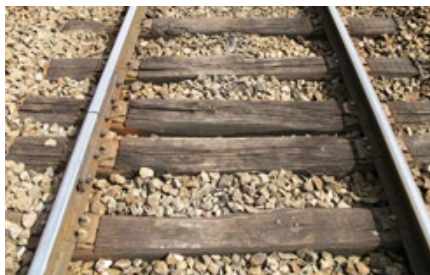
Rails courts sur traverses bois
