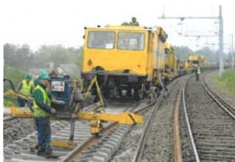
*Longs Rails soudés sur traverses béton*
