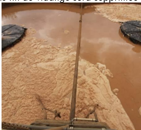
Tirant bassin d'aération
