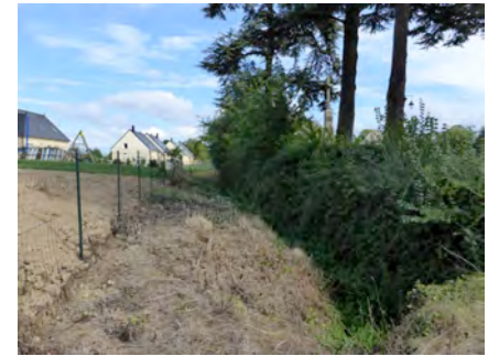
😞 Absence d'espace suffisant pour l'entretien
