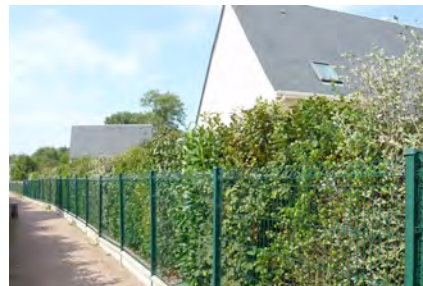
😞 Clôture implantée côté extérieur du lot privé
