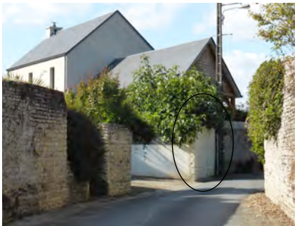
😊 Mur construit dans la continuité d'un mur existant. avec la même hauteur
