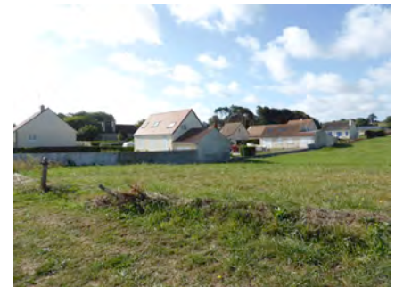
😞 Murets non enduits et absence d'harmonie entre les clôtures
