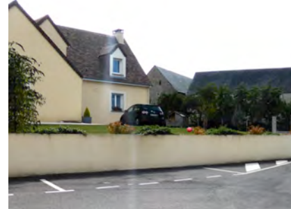
😊 Muret enduit dont la hauteur correspond à la différence de niveaux entre le terrain privé et la voie
