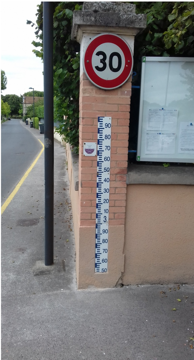
Repère de crue sur la mairie de Louvigny – photo prise par le Cerema
