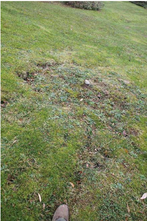
Figure 48 : Fissure eau sol en contrebas de la propriété de la parcelle 0035 (n°96), détail de l'affaissement de la Figure 49.
