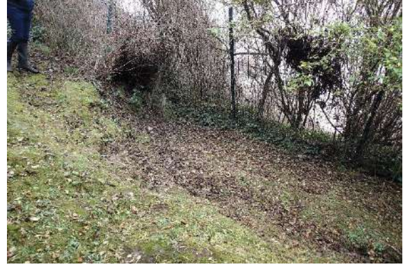
Figure 47 : Affaissement de 70 cm de rejet vertical avec fracture en arrière, à l'ouest du pointement rocheux (parcelle 0035 – n°96).
