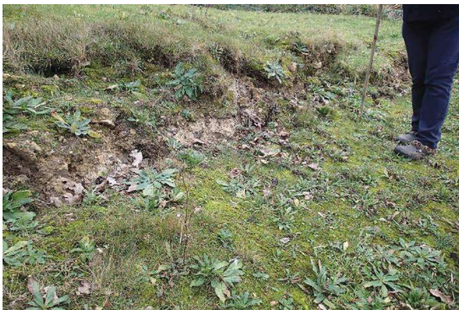
Figure 34 : Fracture du sol en amont d'une zone affaissée d'environ 50 cm (rejet vertical) ; cette fissure NE-SW traverse les parcelles 1000 et 1049 sur environ 25 mètres linéaires.
