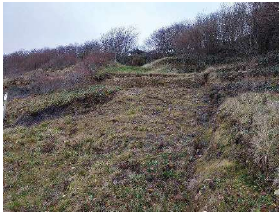
Figure 40 : Terrains glissés de la parcelle 1050 (n°82).
