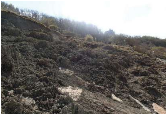
Figure 13 : Enrochements recouverts par les terrains glissés au droit du n°82.
