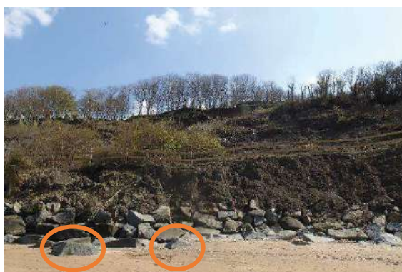
Figure 68 : Parcelle 1000 (n°82) en avril 2021 ; les marnes ont glissé sur les enrochements qui ont été déstructurés dans leur ensemble et ensablés en pied (voir blocs entourés en orange).
