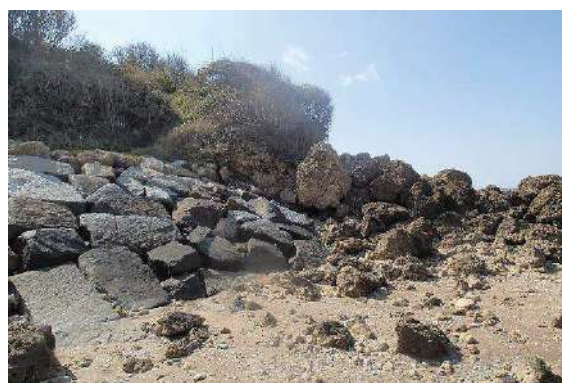
Figure 63 : Extrémité ouest des enrochements accolée aux blocs calcaires affleurant naturellement sur l'estran, devant la parcelle 0999 (n°96).
