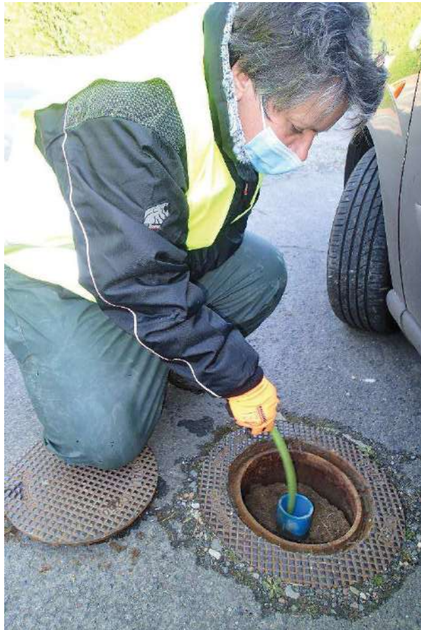
Figure 7 : Début de l'injection d'eau sous pression.
