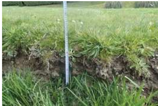
Figure 4 : Détail de la fissure (rejet vertical de 20 cm).
