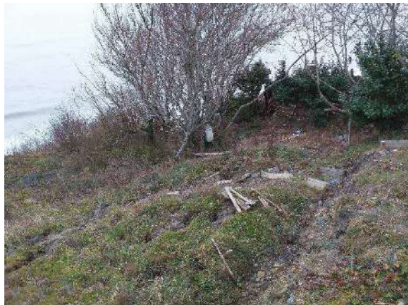
Figure 39 : Terrains glissés sur la parcelle 1049 (n°82).
