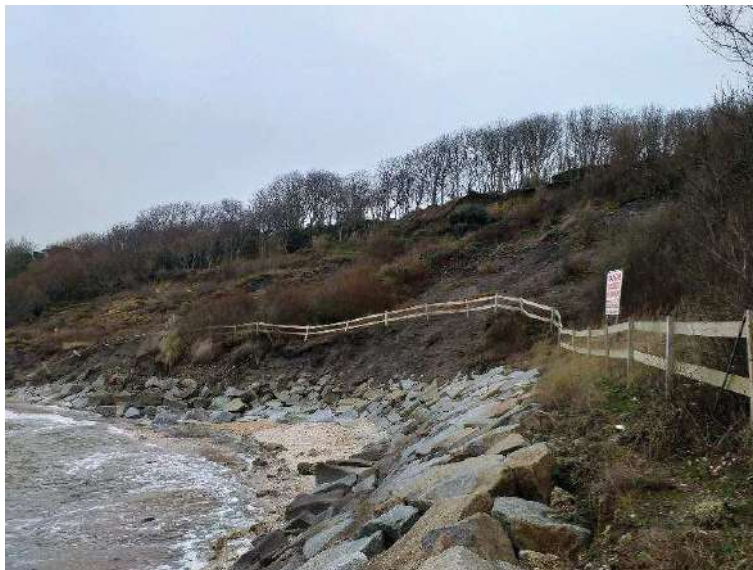
Figure 45 : Terrains glissés à l'est du pointement rocheux (parcelles 1000 – n°82 et 0999 – n°96).
