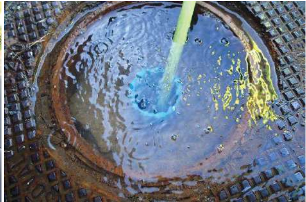
Figure 8 : Lavage jusqu'à obtention d'une eau limpide.
