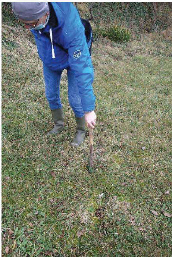
Figure 32 : Fissure au sol ouverte en contrebas de la parcelle 1050 (n°82).
