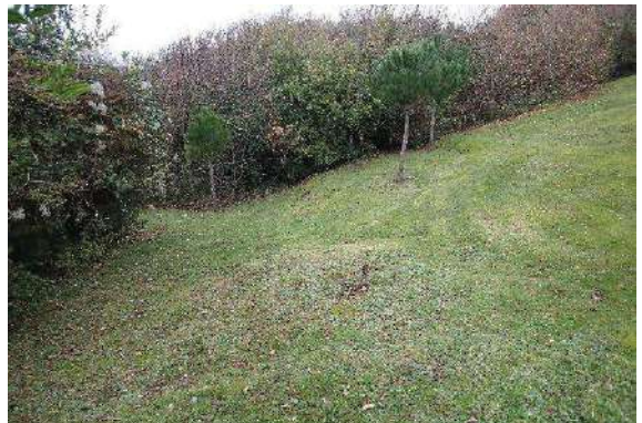
Figure 49 : Affaissement général en contrebas de la parcelle 0035 (n°96).
