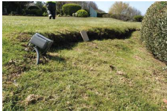
Figure 12 : Fracture au sol d'un rejet vertical d'environ 20 cm entre le terrain de tennis et la maison de la propriété du n°80.
