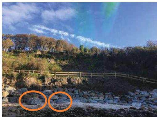
Figure 67 : Parcelle 1000 (n°82) en juin 2020, au moment de la réfection de la barrière bois en limite de propriété.
