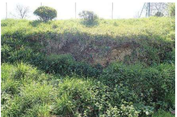
Figure 27 : Fracture avec rejet vertical d'environ 1 m au nord du terrain de tennis sur la parcelle 0779 (n°80).
