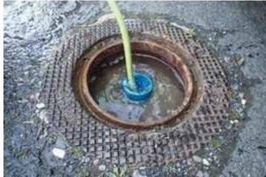
Figure 2 : Lavage du tube inclinométrique I2 (rue de l'Église).
