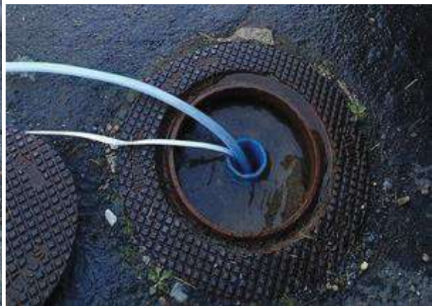
Figure 9 : Pompage de l'eau de nettoyage.
