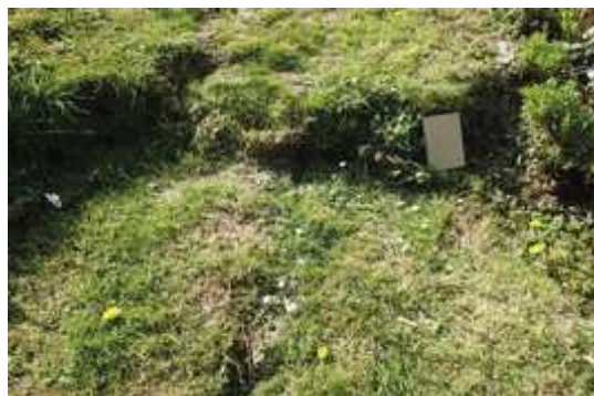
Figure 8 : Rejet vertical d'environ 25 cm en contrebas du terrain de tennis du n°80.
