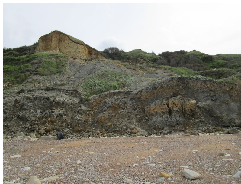
Figure 6: glissement du Bouffay de 2018 ayant emporté deux escaliers d'accès à la plage.
