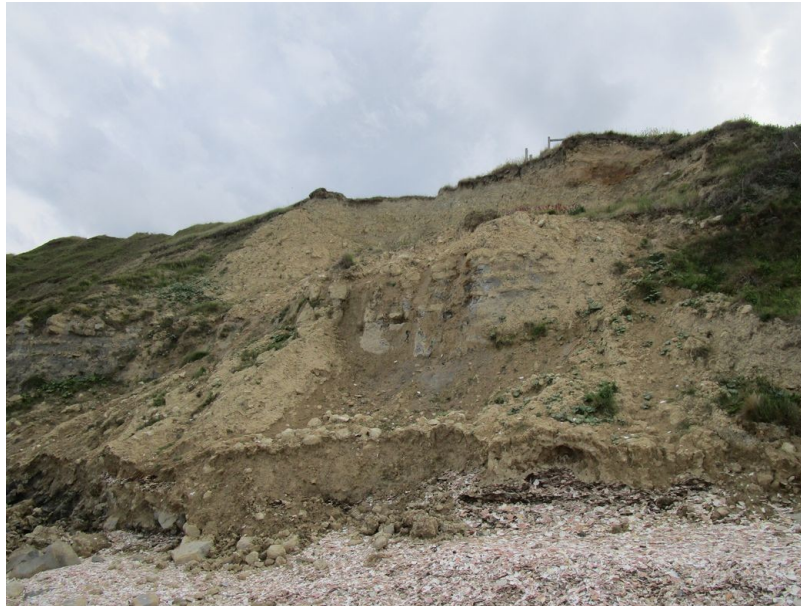
Figure 10: glissement de terrain de la Tour Vauban de février 2021.
