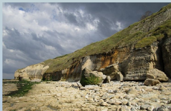
Décrochement de gros volumes de blocs en pied de versant
