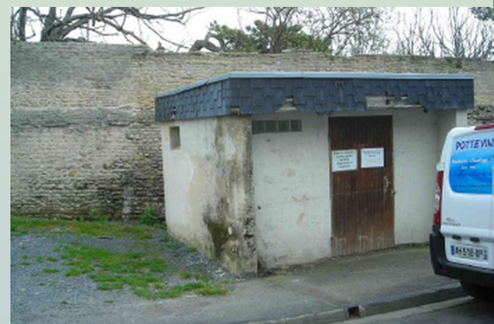
Ancien transformateur EDF
