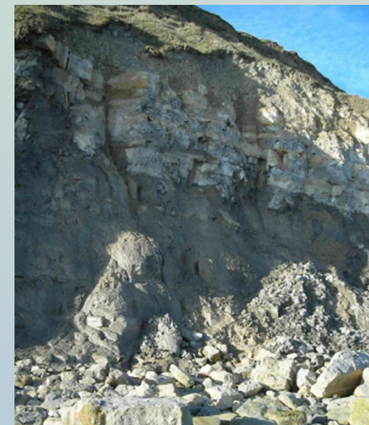
Chutes de blocs au niveau des Marnes de Port-en-Bessin
