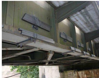
Figure 16: Absorbeur sur platelage
