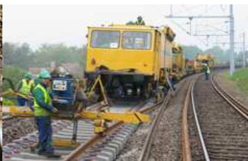
Figure 12: Longs Rails soudés sur traverses béton
