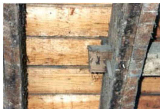
La clavette s'insère dans sa mortaise
