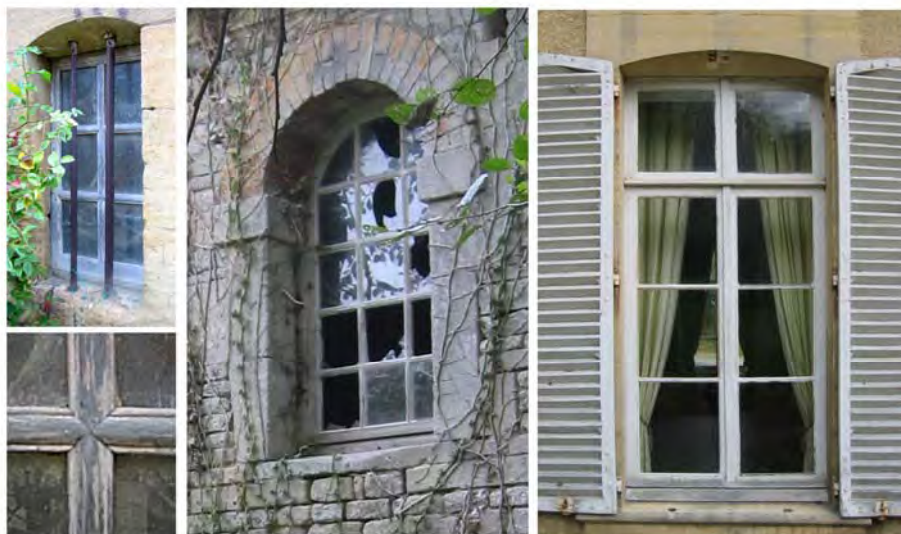
Châssis de fenêtres à petits carreaux
