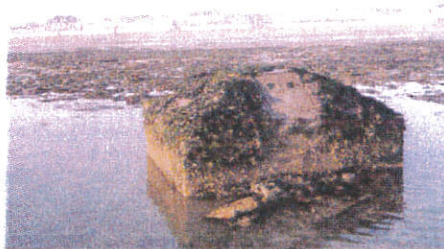
Vue de la prise d'eau de mer
