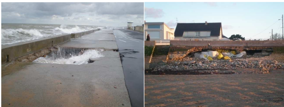
(Digues d'Asnelles avant et après la tempête de mars 2013)
