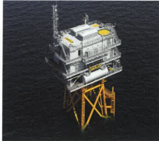
Représentation d'un poste électrique en mer sur fondation de type jacket (à gauche), et poste électrique en mer du parc éolien Dong Energy de Walney (à droite)
