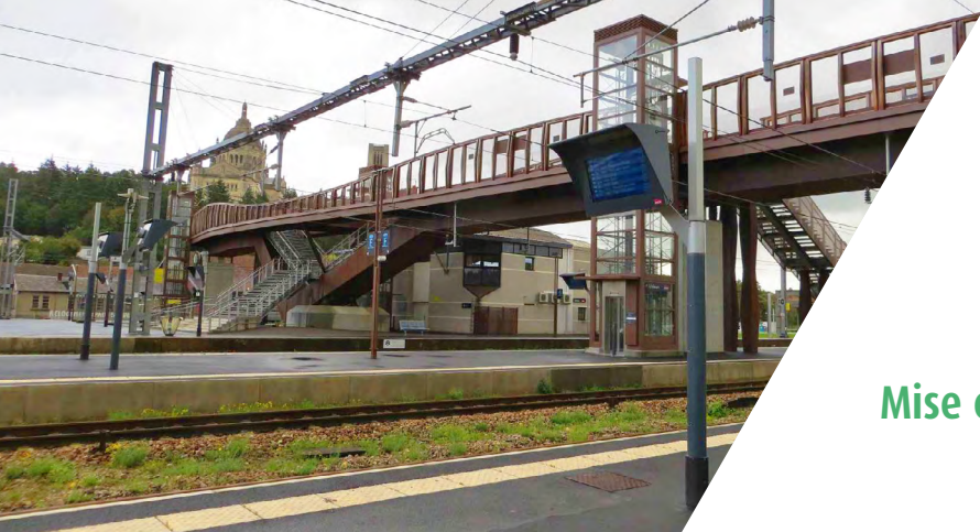
Gare de Lisieux - Passerelle au-dessus des voies ferrées
