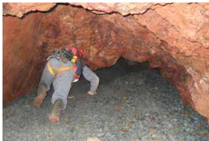
Travaux de comblement dans la mine de May-sur-Orne en 2019
